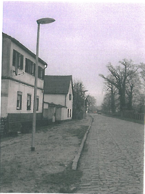
(installierte Anlage in alter Genthiner Straße in Genthin OT Parchen)
