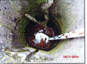
2 Mit diesem Stauschacht konnte bei Trockenheit das Dränagesystem eingestaut werden Ein- und Auslauf AZ DN 200
