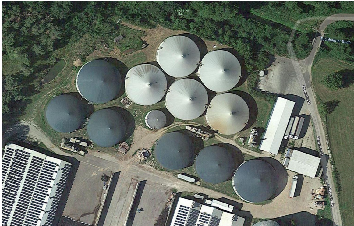
Abb1: Luftbild der Biogasanlage Gladau, Quelle: Google Earth
