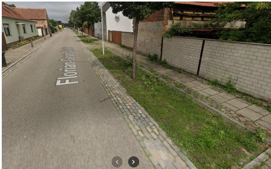
Ein Bewuchs (Rasen oder andere Gräser) mindert die Funktionsfähigkeit der Versickerungsfläche. Bei einer Versickerungsfläche ist es wichtig, dass das Wasser effektiv durch die Oberfläche fließen und in den Boden eindringen kann. In der Versickerungsfläche ist Schotter und Vlies eingebaut worden. Das Vlies dient als Filter, um Schmutz und andere Partikel zurückzuhalten, während das Wasser durchsickert.
